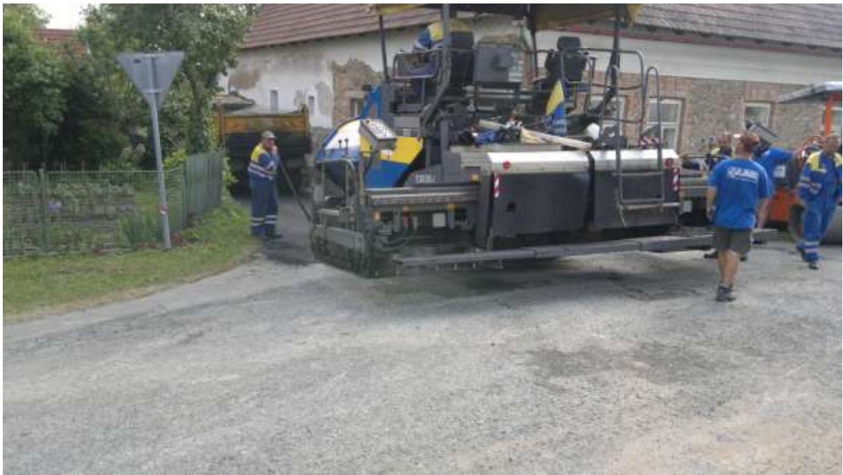
Pokládka asfalt-betonu.
