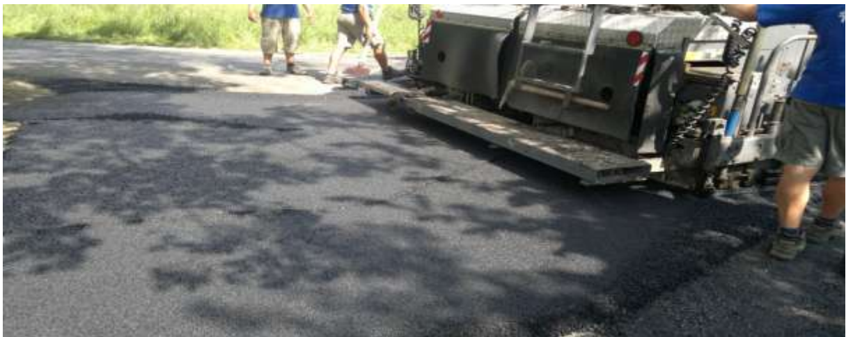
Napojování na MK OPRAVENOU V ROCE 2011 ( Rozvoj vesnice 2010 )
