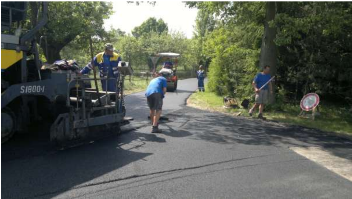
Pokládka asfalt-betonu.
