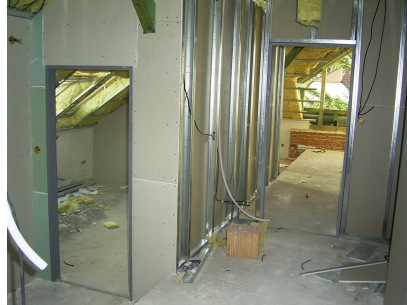
Stavba příček v bytě
