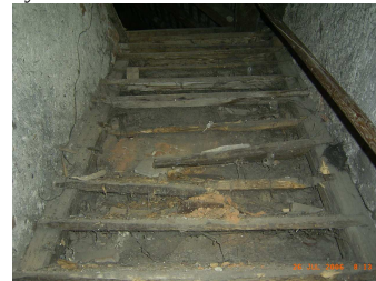
schody na půdu
