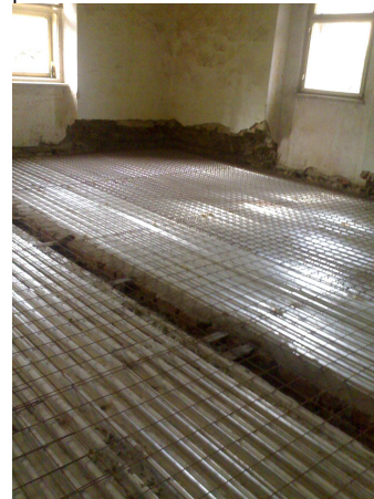
betonáž stropů konímy
