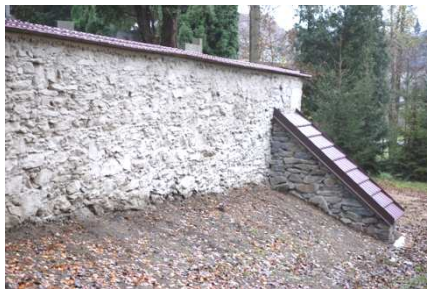
Oprava hřbitovní zdi
