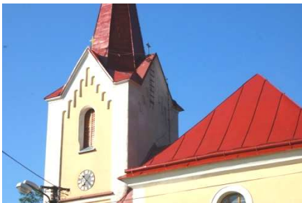
Oprava nátěru střechy kostela
